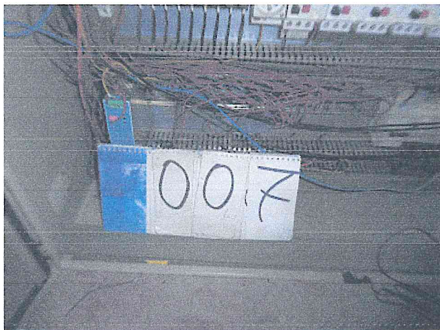
Miejsce po wymontowanym module sterowniczym FX2N4AD
